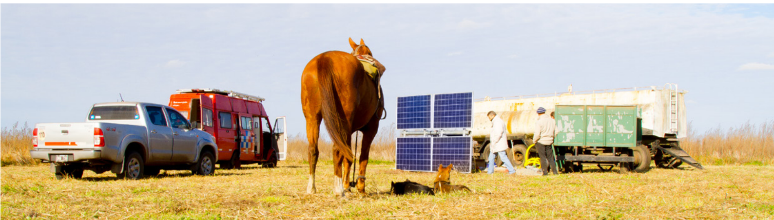
Lorentz PS600 para ganadería. Altura total: 10 metros. Caudal diario 23 .000 litros. Rawson, Buenos Aires
